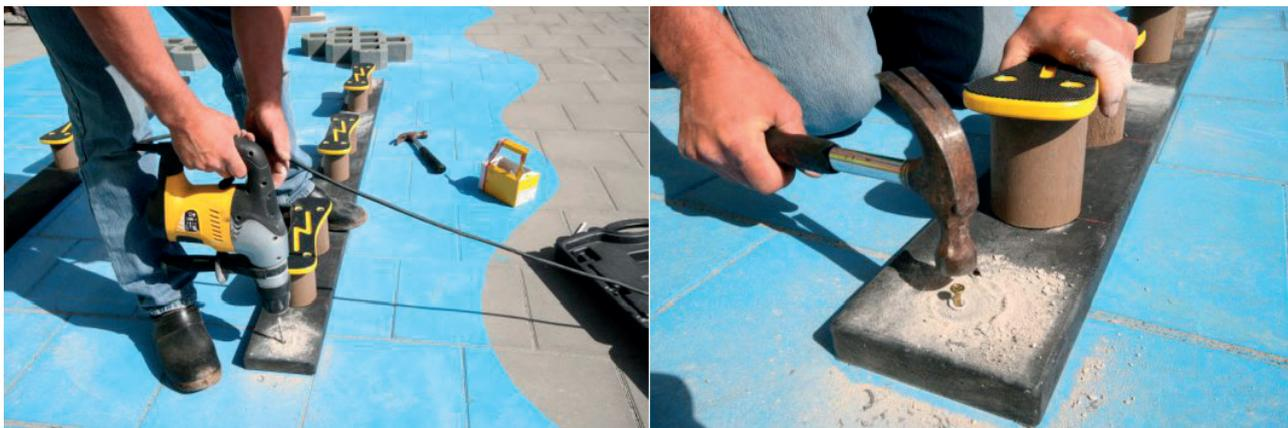
Positionnez les obstacles au bon endroit et forez dans les trous prévus au moyen d'une mèche à pierre de 8x100mm. Insérez-y des chevilles, vissez ou frapper doucement avec un marteau pour ne pas plier la tête de vis
