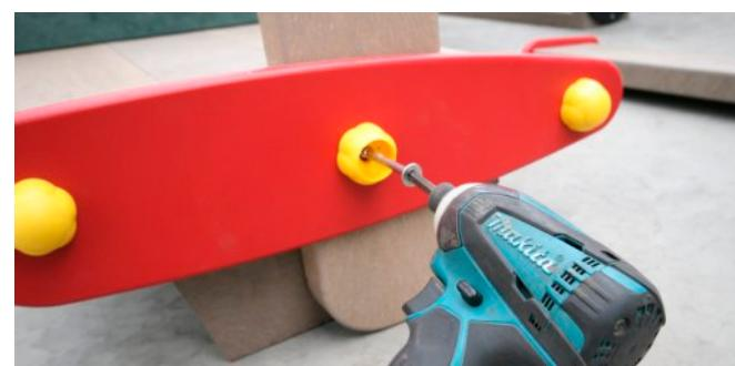
Assemblez les supports des ailes au moyen des deux vis de 8 x 120 mm (Torx 40) fournies et des deux caches jaunes.
