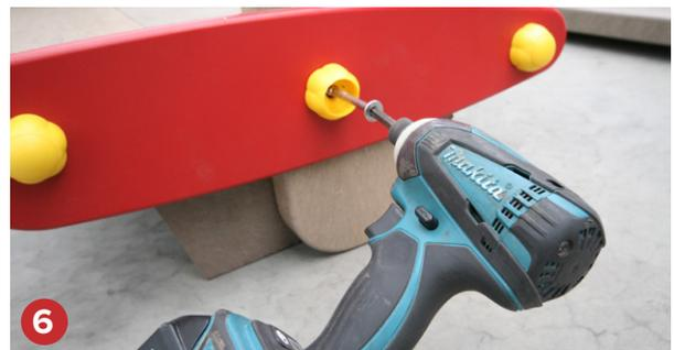
Fixez les supports des ailes en utilisant les deux vis fournies 8x120 (Torx 40) et les deux capuchons jaunes.
