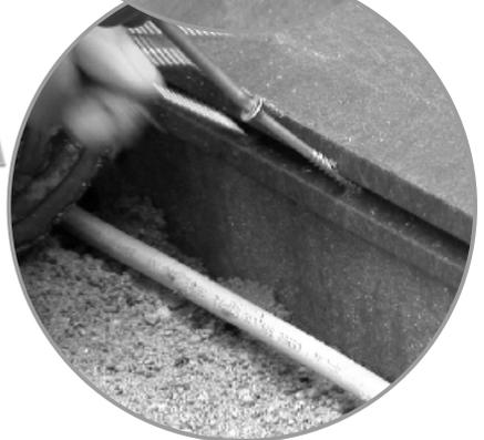
Diese Fixierung kann auch geschehen durch die Schrauben unsichtbar zu befestigen. Es muss langsam geschehen und vorbohren ist empfehlenswert. Diese Fixierungsweise soll während die Verlegung geschehen und nicht nachträglich.
