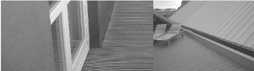
Minimalste Temperatur in Westeuropa = ca. - 20°C. Maximale Temperatur, bei z.B. schwarzen Brettern, in voller Sonne = ca. 50°C. Geht man bei der Verlegung der Bretter von einer normalen Umgebungstemperatur, von 10 bis 20°C aus, dann ist der maximale Temperaturunterschied ca. 40°C nach oben (Ausdehnung!) und auch ca. 40°C nach unten (Schrumpfung!) Diese Werte beweisen die Notwendigkeit zu rechnen mit Ausdehnung und Schrumpfung.
