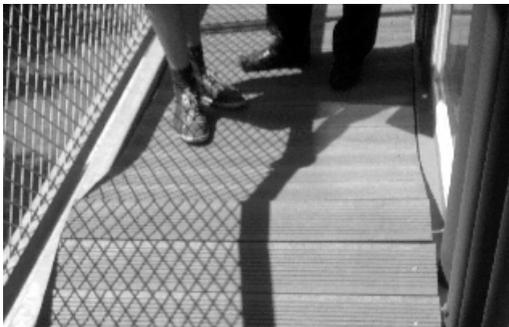
Das Bild zeigt uns die mögliche Auswirkungen auf die Terrasse wenn nicht gerechnet wird mit die Ausdehnung der Unterkonstruktion. Es ist erforderlich einen Zwischenraum zu lassen.
