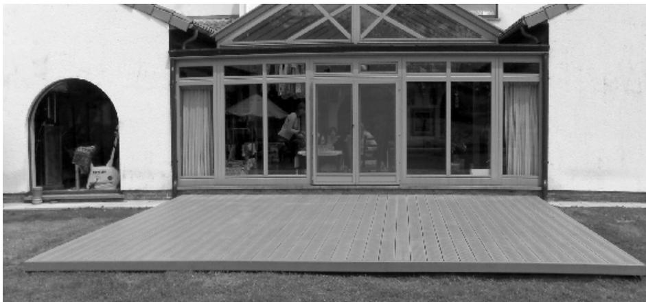
Rechteckige Terrasse mit Einfassung. Die Unterkonstruktion ist an die Fassade fixiert.
