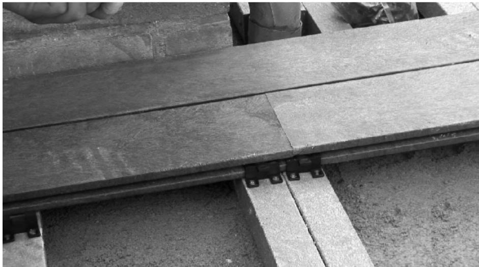
Die Terrassenbretter werden ebenfalls mit Hilfe der Gova-Fix-Verbindungsplatten in Längsrichtung miteinander verbunden. Anschliessend können die „verlängerten“ Terrassenbretter umgedreht und in das Gova-Connect eingeschoben werden.
