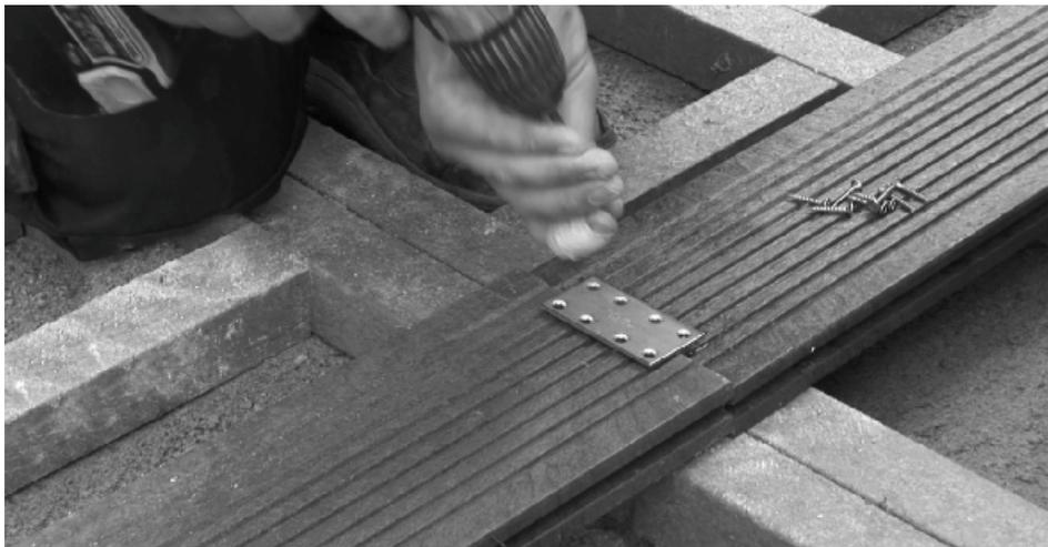
Durch diese Art der Verbindung von zwei hintereinander verlegten Terrassenbrettern werden Spalte zwischen den Terrassenbrettern oder eine Krümmung der Bretter vermieden.
