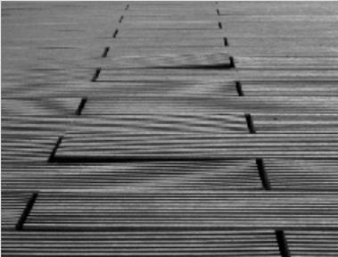
Obschon die Bretter in Verband verlegt wurden, sind sie nicht in Längsrichtung verbunden. Ausserdem wurden keine Doppelunterlegpfosten verwendet. Spalten und wippende Brettenden können die Folge sein.
