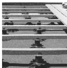
Govalift 5 types pour plusieurs hauteurs Le Govalift doit supporter les piquets eco chaque 35 cm Usage per m 2 : 6,5 pcs.
